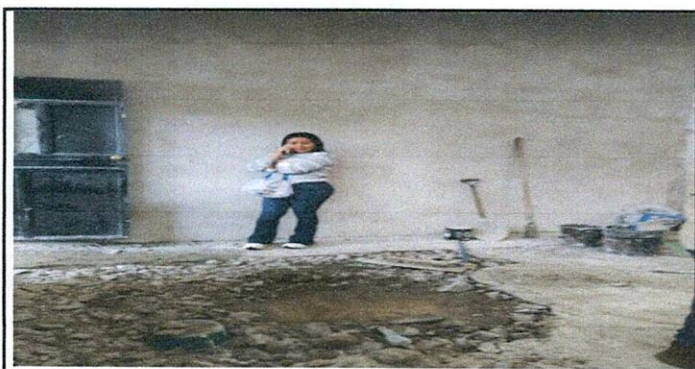
Cernido en proceso de paredes de aulas
